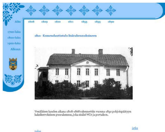
Kuva 15. Komendantintalo kertoo 250-vuotiaasta kivitalosta, joka toimii nykyään Loviisan museona. Näyttely perustuu hyvin vahvasti kronologiseen esitystapaan, joka näkyy myös sivuston rakenteessa. Valittuina vuosina kuvatut tapahtumat tuntuvat varsin satunnaisilta: osa kertoo talosta, osa Loviisaan liittyvistä tapahtumista ja koko 1900-luvun historia Loviisan museosta, vaikka museo asettuikin komendantintaloon vasta 1950-luvun lopulla. Lähde: http://www.loviisa.fi/museum/ovi.htm (27.2.2005)
