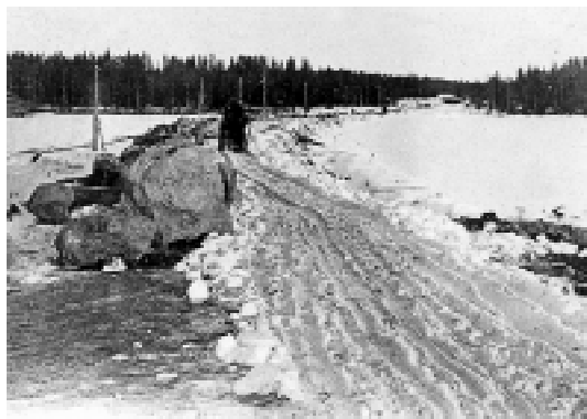
Hevosilla ajettiin 20 000 kuutiota liejusavea leikkauksesta lähellä Nurmesen asemaa (Rakennustaito 21/1911, s. 251). Kuva: NKM 2851: Maaleikkaus ratalinjalla 1 km Mikonsalmesta 1909.
