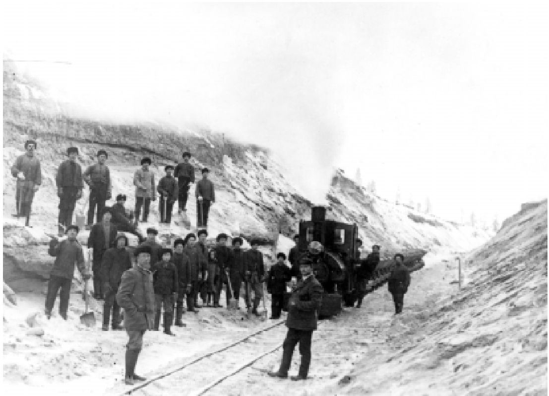
Veturileikkaus Rovaniemen radalla Muurolassa. Etualalla seisoo työnjohto ja miehiä on kaksi yhtä santavaunua kohden. Kuva: Muurolan vaunumäki Kemän ja Rovaniemen välisellä radalla. Kunta: Rovaniemi. Aika: 1909. TA.
