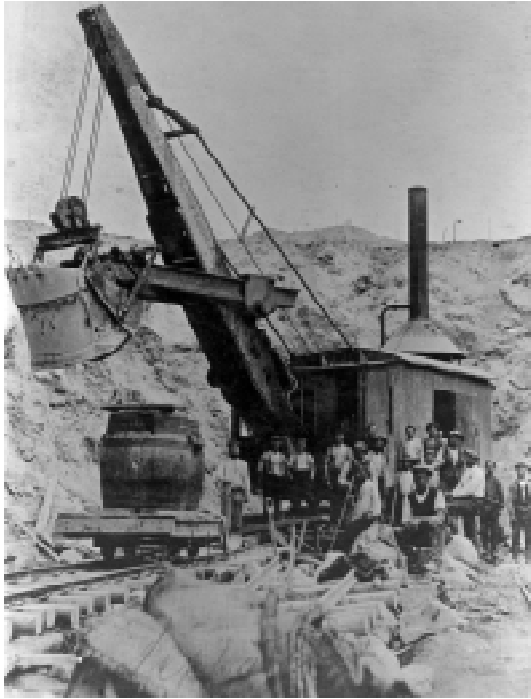
Hullu-Jussi Leppälähdellä Jyväskylän ja Pieksämäen välisellä ratatyömaalla vuonna 1917. Rautakangilla miehet irrottivat mäestä pakkaantunutta soraa koneelle ja etualalla olevan raiteen avulla kaivinkoneen paikkaa voitiin vaihtaa. Kuva: Pieksämäki-Leppälahti-rataosuuden rakentaminen 1917. TA.
